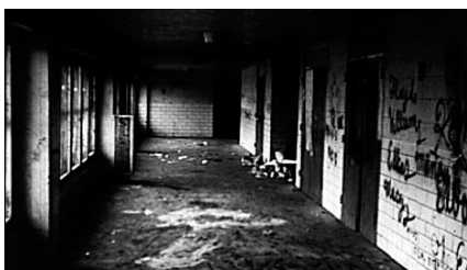
Demolirana komunalna prostorija
