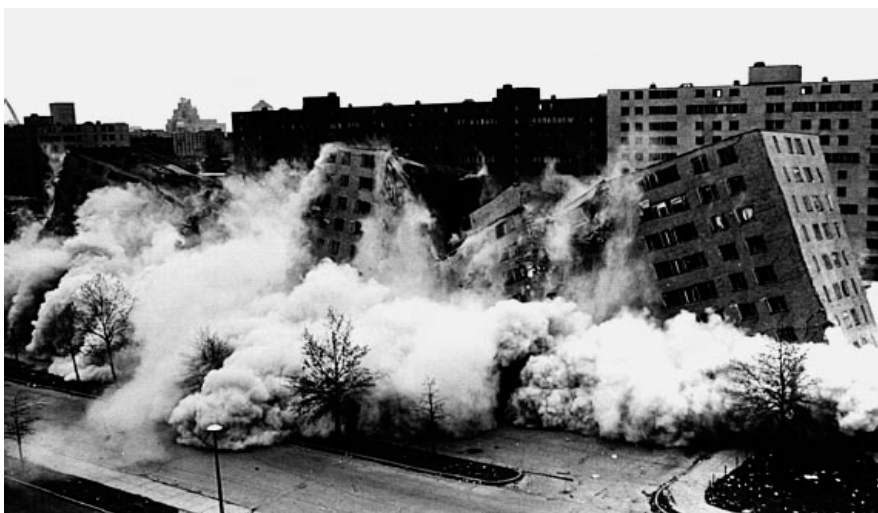
Rušenje Prut-Igo stambenog kompleksa
